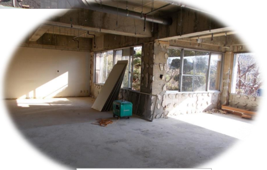
1階事務室・役員室
